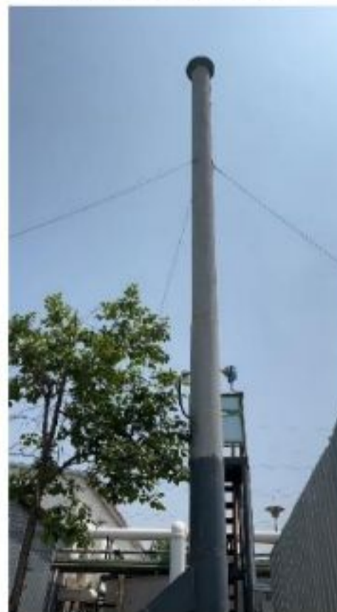
DA006废气排气筒
