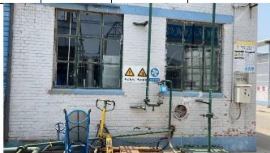
污水处理站外部
